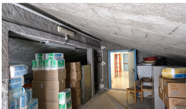
Sottotetti Ali laterali da isolare a pavimento
