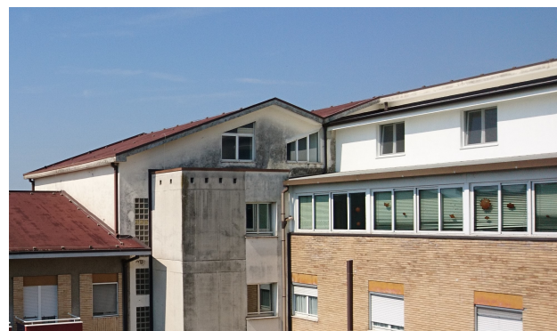
Copertura a falde corpo centrale da coibentare
