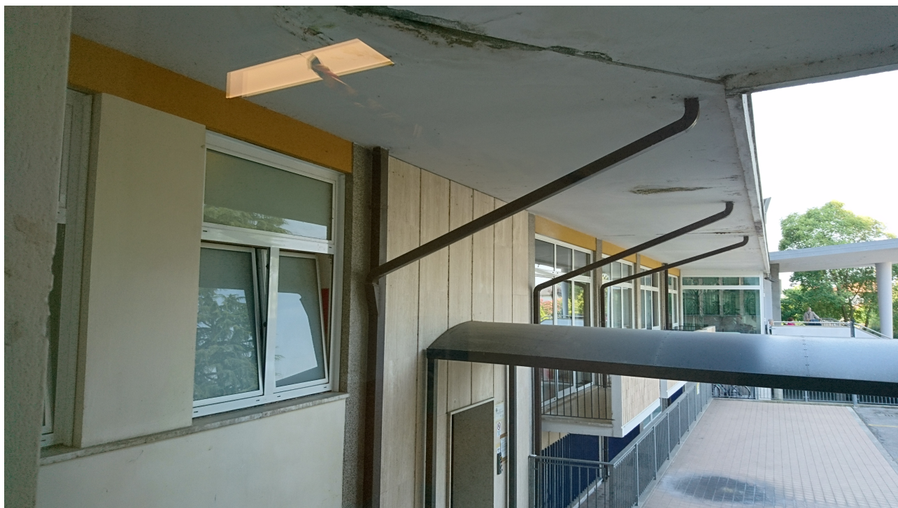
Pensilina su facciata principale e vari elementi interferenti per la realizzazione del cappotto
