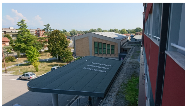
Ingresso principale e fabbricato sala da pranzo da coibentare
