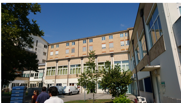
Facciata sud-est del corpo principale da coibentare
