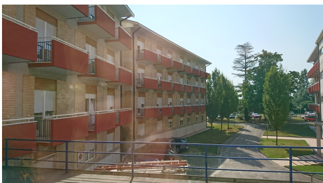
Ala laterale 1 da coibentare e vista cortile interno
